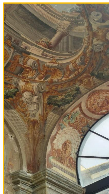
Figura 4 - Ambienti situati al piano II, finemente affrescati
